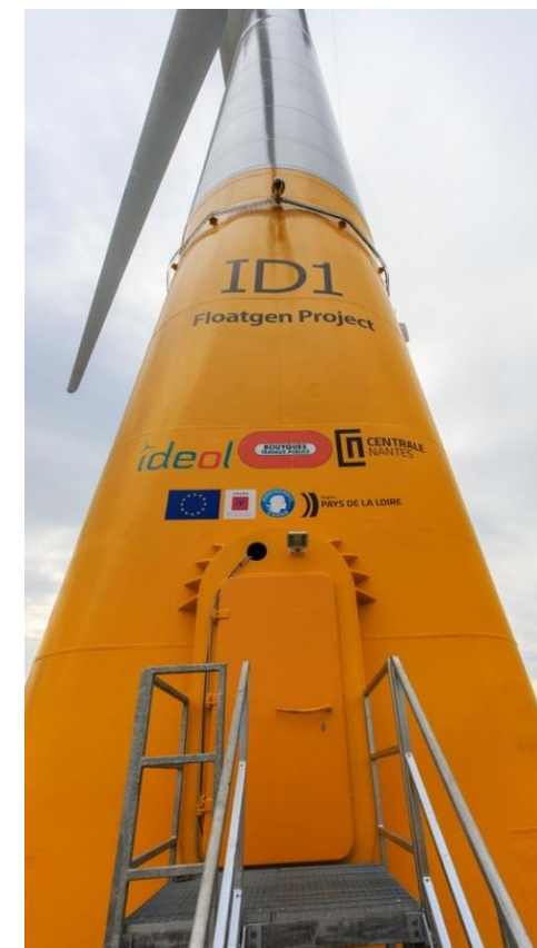
FloatGen "ID1" (Source: live.floatgen.eu )
